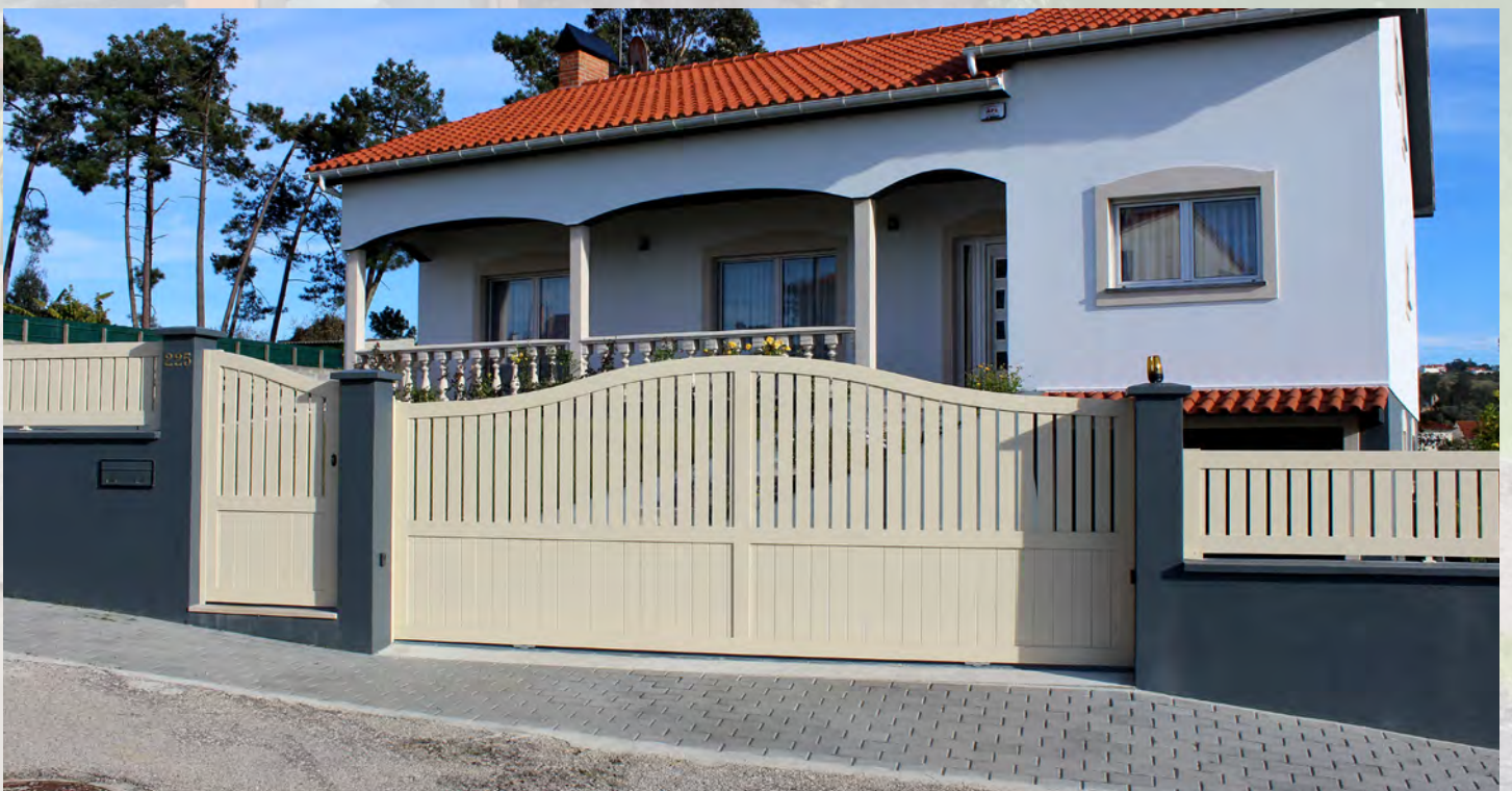
OBRA COMPLETA com portão e cancela com chapa dupla e réguas de 80 mm
