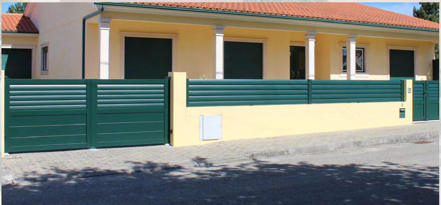
OBRA COMPLETA com portão batente , cancela e gradeamento
