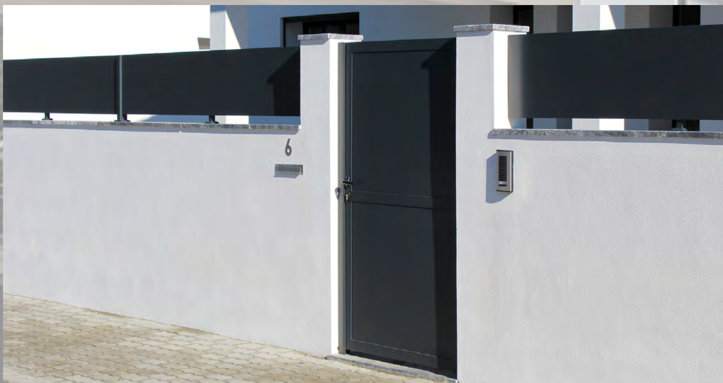
CANCELA E GRADEAMENTO com chapa quinada em tabuleiro
