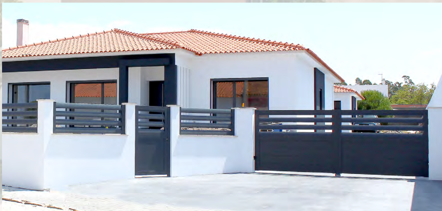
OBRA COMPLETA Lâminas Quebra-sol com espaçamento de 5 cm
